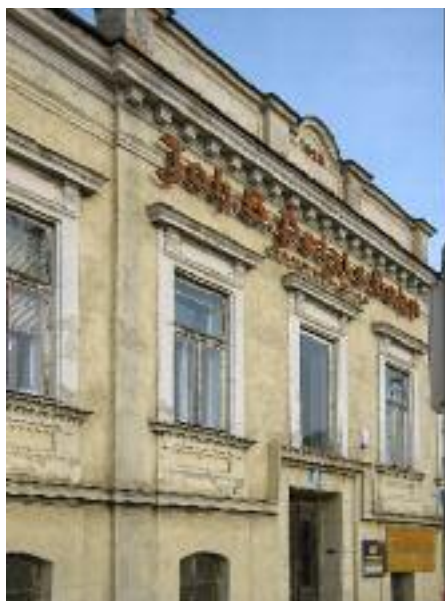
Abb. 32: Was wird von der ehemaligen Seilerei in der Donaufelder Straße 157 nach der Erweiterung um zwei Stockwerke bleiben?
