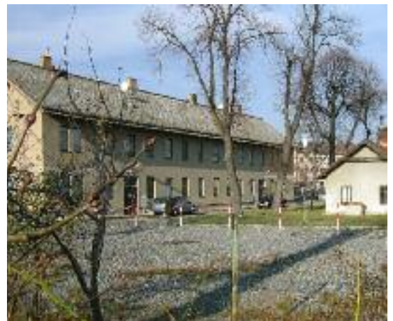
Abb. 35: Nordwestbahn-Kolonie: Detail-Foto, von der Lokomotivgasse gesehen. Im Vorder- und Hintergrund standen bis vor wenigen Jahren die beiden Pawlatschen-Trakte, heute Parkplätze.
