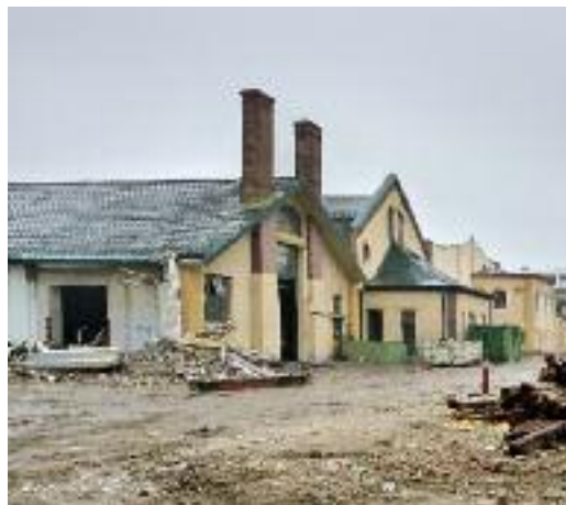
Abb. 34: Abriss der ehemaligen Lohner-Werke (Donaufelder Straße 77-79) im Jahr 2009: nichts blieb von diesem Stück Floridsdorfer Industriegeschichte erhalten.
